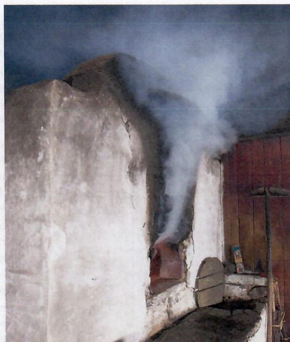
Brasan har nyss tänts. Röken lämnar ugnen genom ugnöppningen och låghålet och stiger mot taket..
