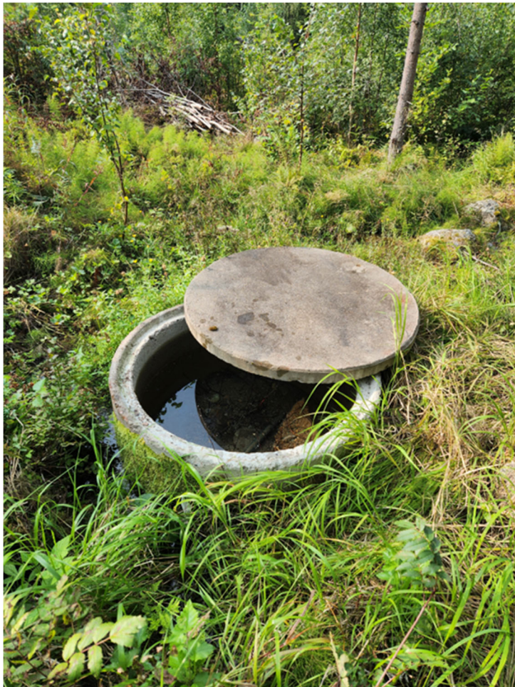
Figur 25. Källan som förser Brännåsens fäbodrar med sommarvatten (N 6869613, E 597451, ca 254 möh. Kond 6,0 mS/m, temp 8,3 °C /240831/.).
