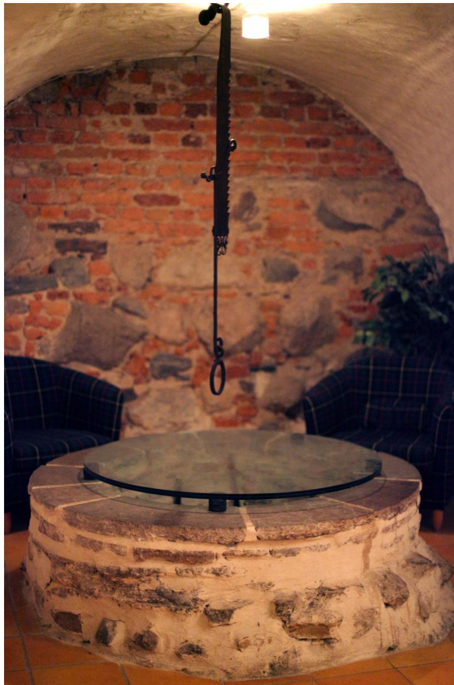
Brunnen i källaren Kornhamns torg 51, med en glasskiva som bord över brunnen
